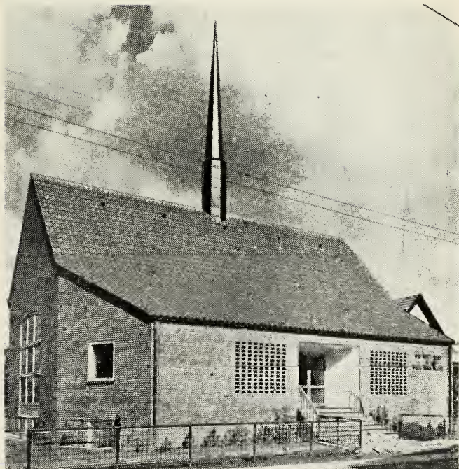
Amager grens kirkebygning. Indviet 24. september 1955.
