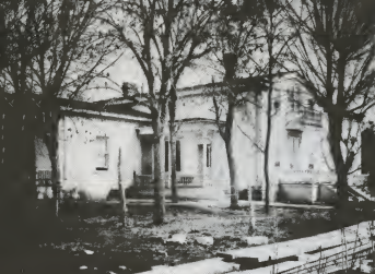
„Det hvide Hus“ eller „Hovedbygningen“
