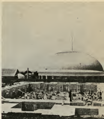
Seksten fod tykt fundament til Salt Lake templet (ca. 1870). Fotografi taget af Charles R. Savage.
