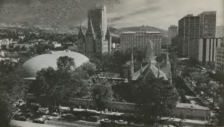
Templet, Assembly Hall og kirkens kontorbygning i Salt Lake City.
