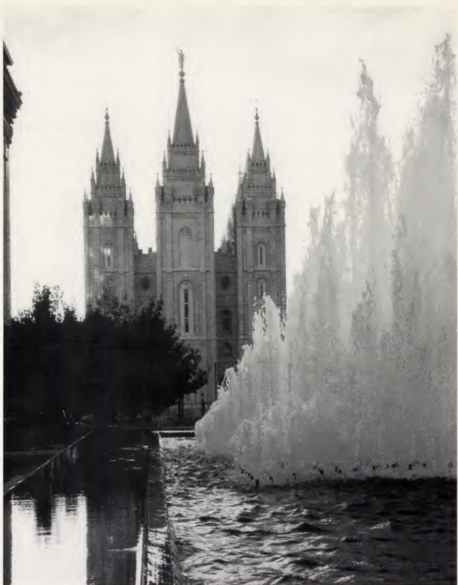
Springvandet på pladsen foran Kirkens kontorbygning synes at efterligne spirene på templet i Salt Lake City.
